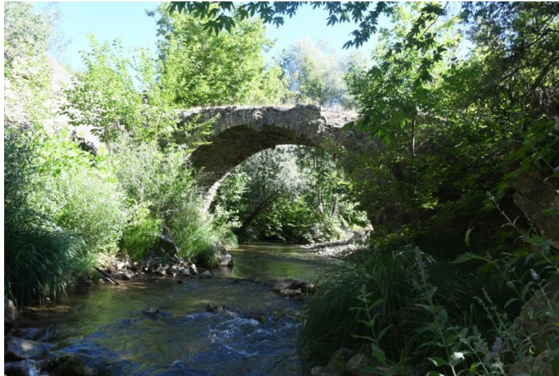
Şekil 2: Himmetli Köprüsü mansap cephesinden genel görünüm
