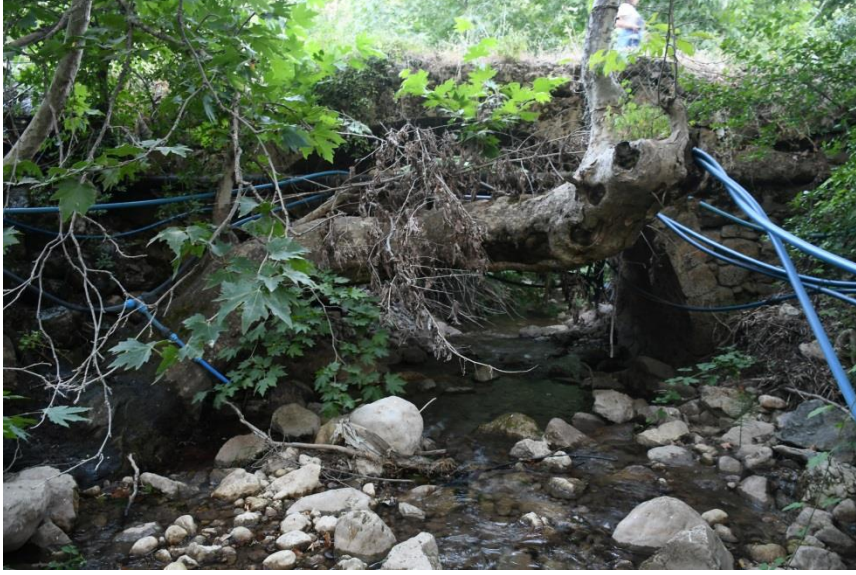
Şekil 8: Obruk Yolu Taş Köprüsü mansap cephesi görünümü
