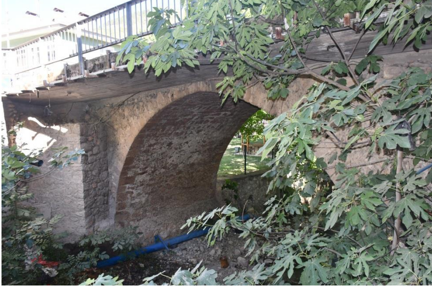
Şekil 3: Fatih Mahallesi Taş Köprüsü mansap cepheden görünüm
