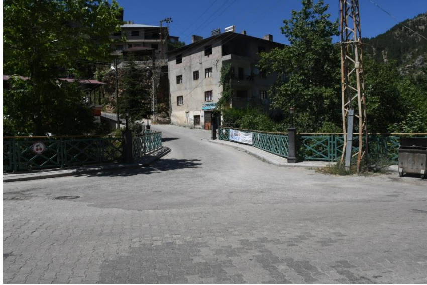
Şekil 5: İslam Mahallesi Taş Köprü genel görünüm
